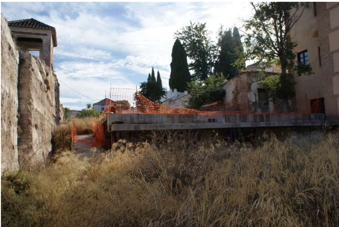
Plataforma de hormigón armado para pasarelas del antiguo Paseo Lineal. Vista desde el oeste y hacia el este
