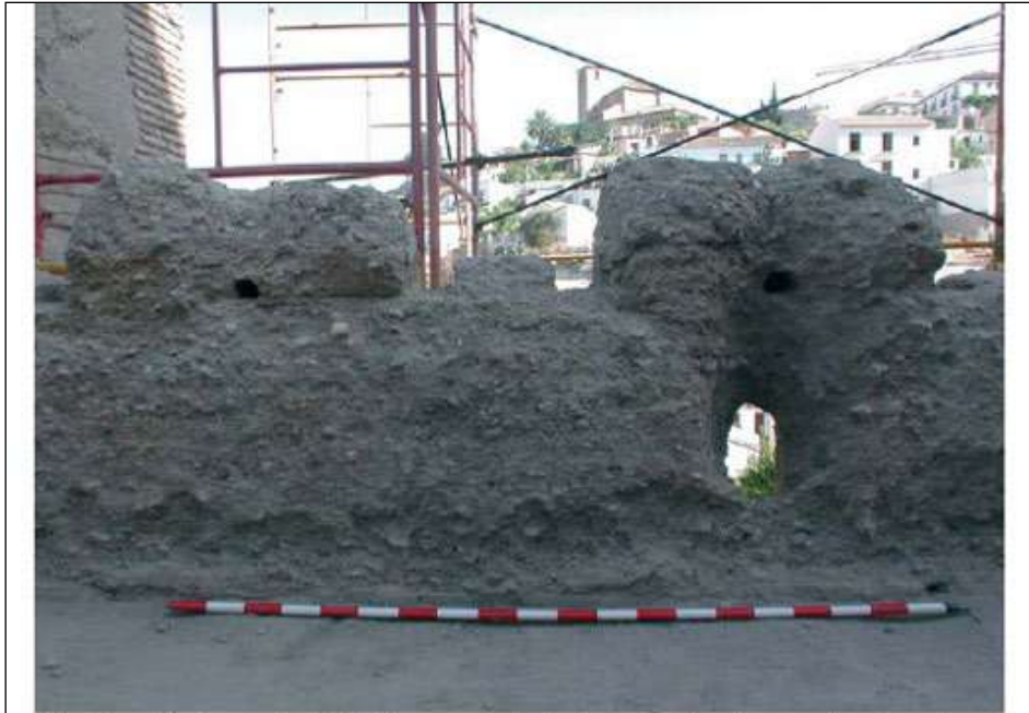
Lámina 10 (superior). Vista general del parapeto almenado durante el proceso de excavación previo.
