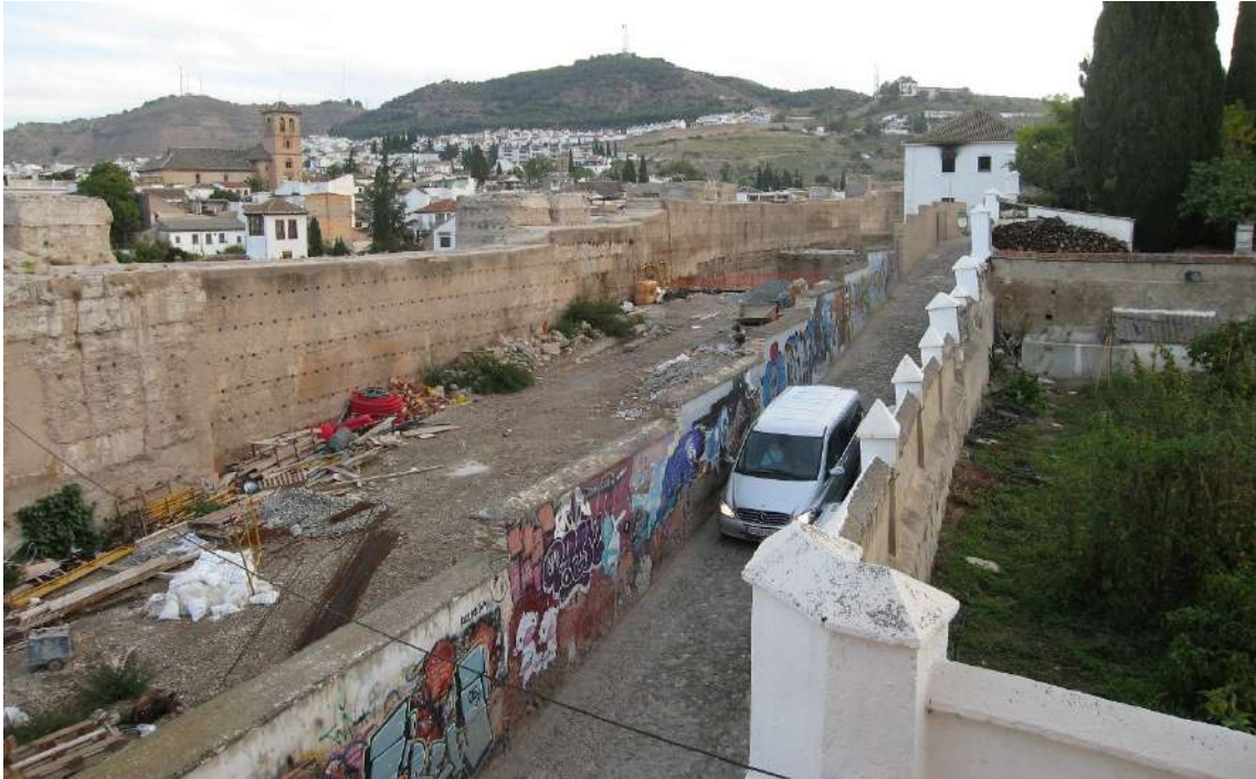
Vista de la zona central del sector A desde el oeste hacia el este. Losa de hormigón que cubre los rellenos junto a la muralla exterior. Fotografías Fundación Albaicín
