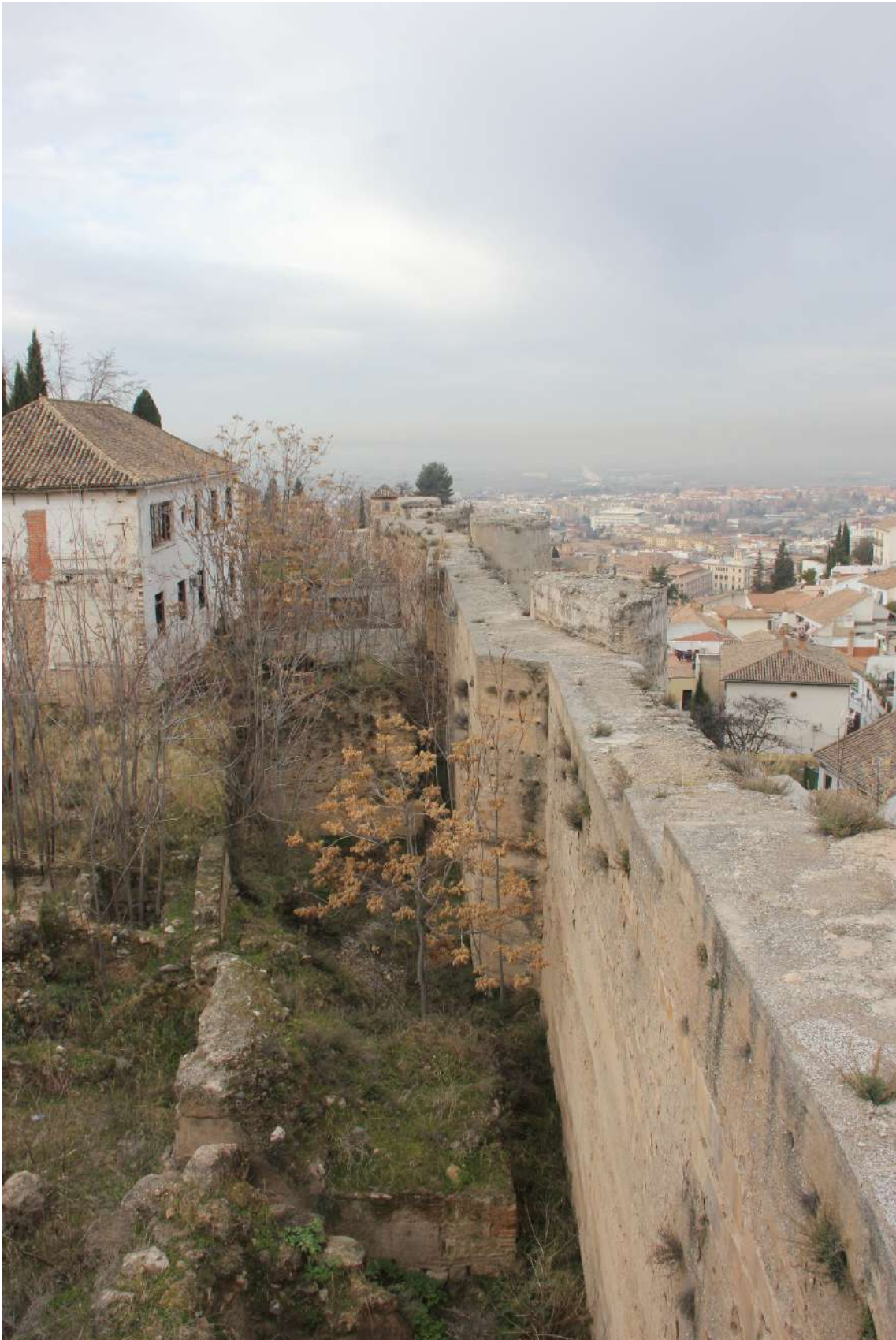
Zona A junto a la torre T11i tras la excavación arqueológica. Al fondo se aprecia el perfil del relleno homogéneo a retirar y la losa junto al centro Guadalinfo. Vista desde el oeste hacia el este
